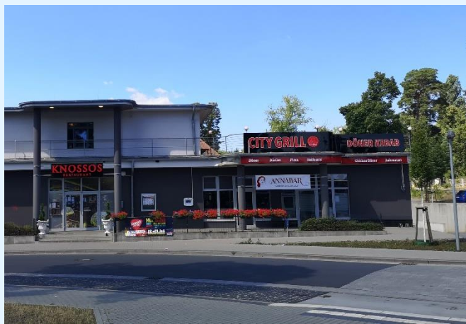
Foto: J.Stärke – Edekegebäude am Bahnhof
